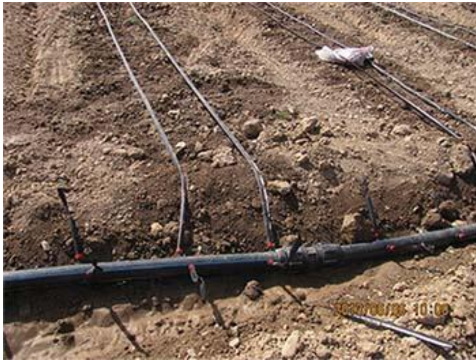
شکل ۱۶- سیستم تیپ جهت آبیاری مزرعه فلفل
