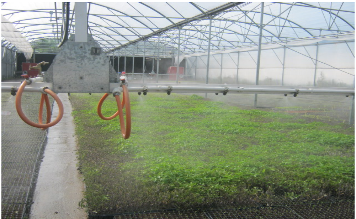
شکل ۱۱- نمونه ای از سیستم آبیاری در یکی از گلخانه‌های مدرن تولید نشاء
